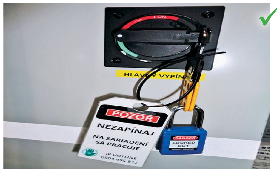
Fotografia č. 7: Uzamknutie a označenie hlavného vypínača vo vypnutej polohe
