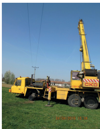
Kontakt žeriava s 22 kV vedením
