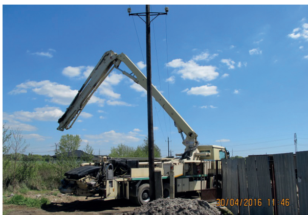
Kontakt betónovej pumpy s 22 kV vedením
